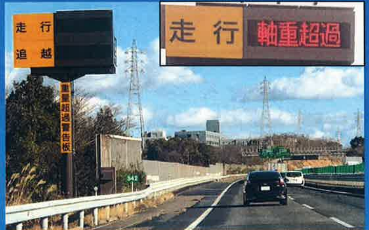
高速道路本線での「軸重超過」表示
